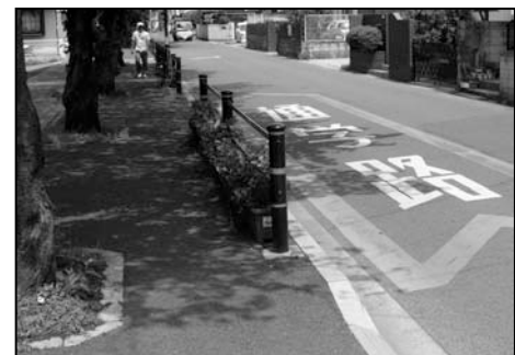
▲プランターの設置された歩道
